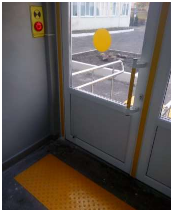
Рисунок 1. Оборудование входной группы
