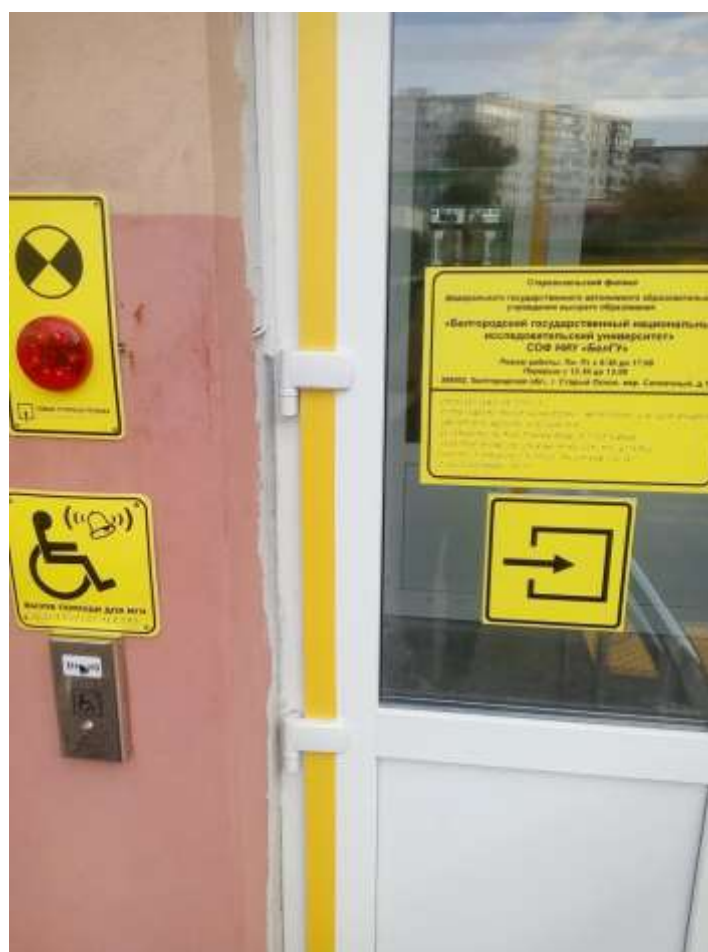
Рисунок 2. Оборудование входной группы
